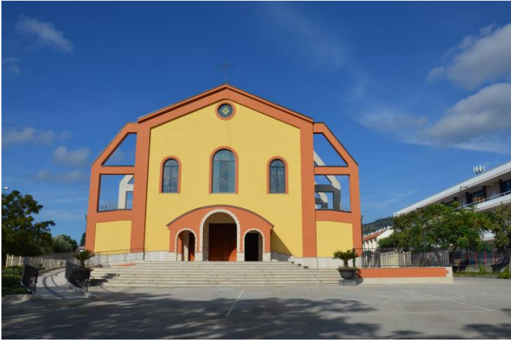
Ristrutturazione Chiesa S. Giuseppe Artigiano – Lamezia Terme
